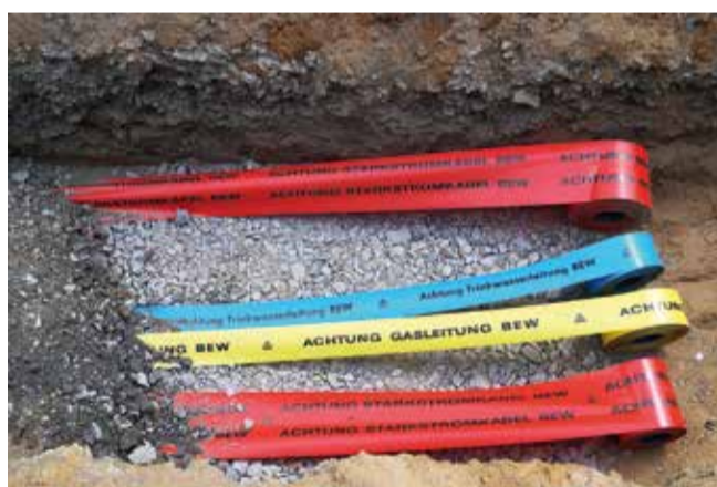
Warum sind die Farben der BEW eigentlich rot, blau und gelb? Die Sicherheitsbänder, die über den Versorgungsleitungen in der Erde gelegt werden, geben die Antwort
